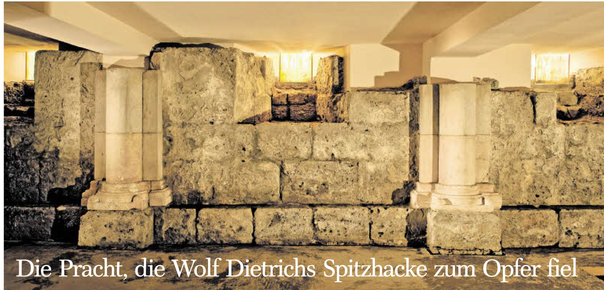
Das romanische Mauerwerk samt Säulen und drei Fensteröffnungen an der Nordwand der Domkrypta, darüber die Betondecke aus 1959. Diese ist (geplant und gestaltet von Architekt Andreas Knittel) frisch saniert, gedämmt und ergänzt. Bis 1956 war dieser Rest der 1219 geweihten Krypta verschüttet. Bilder (2): SNS, ZENZMAIER
